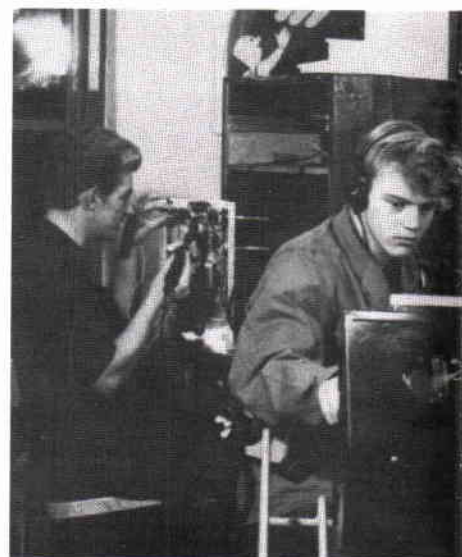
Folke Sundholm med en av telemontörerna. Funktionskontroll pågår av den egenhändigt byggda radiosändaren (Hartley-kopplad oscillator) med hjälp av en gammal flygradiomottagare (FR2?).
